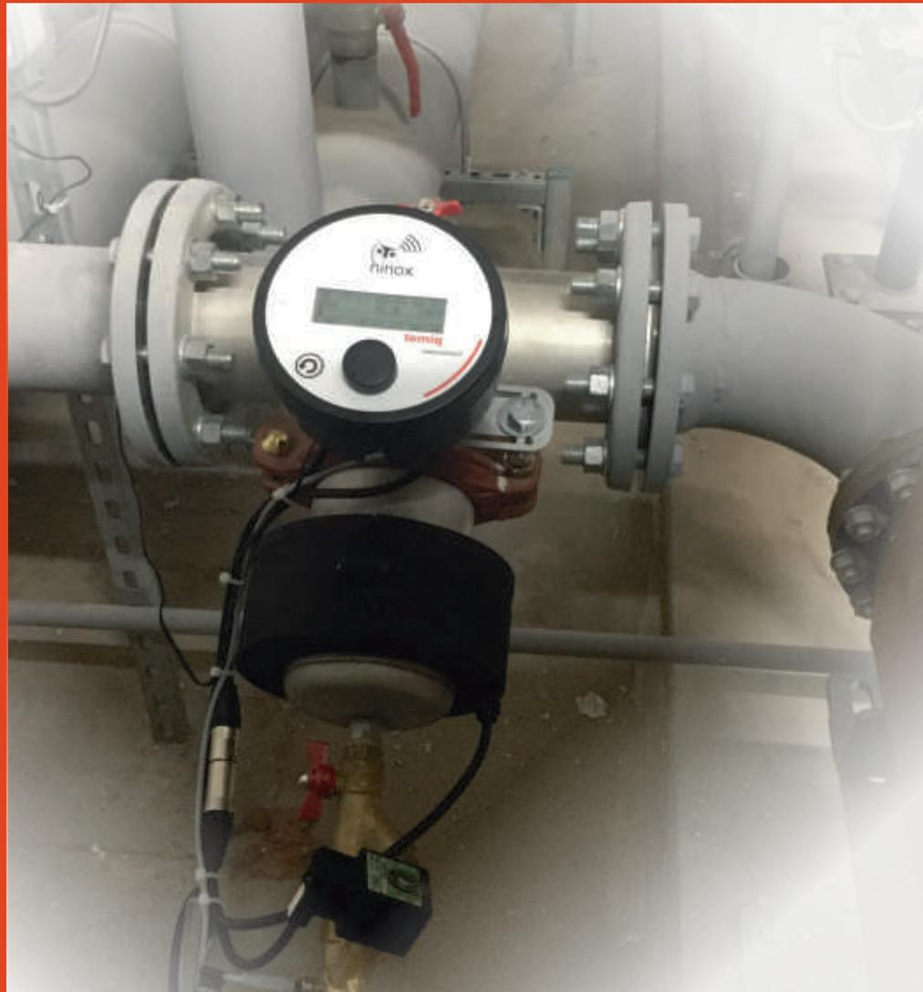
Désemboueur magnétique de la gamme Ninox® Large (Ninox L 100) installé en ligne sur un réseau de chaleur
